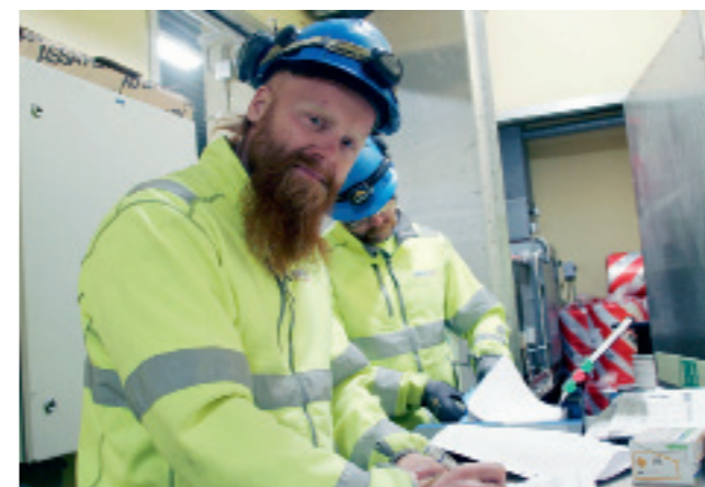
Carl Selin var ledande montör vid ställverksbytet...
