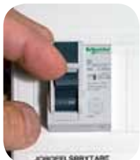
Jordfelsbrytaren bör ”motioneras” en gång i halvåret för säker funktion.
