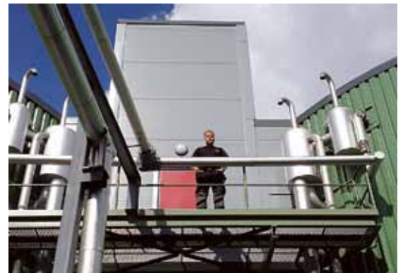
Carl Selin, ledande montör, mellan de båda rökammarna på biogasanläggningen.
